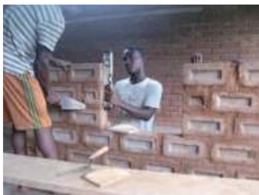
Exercices de maçonnerie
