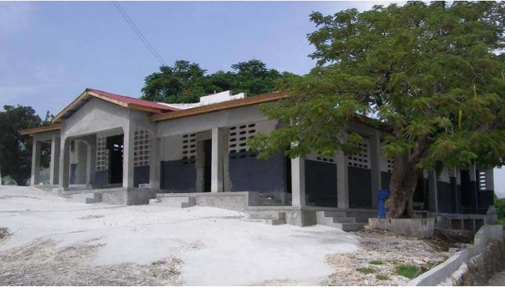
Bâtiments après sécurisation
