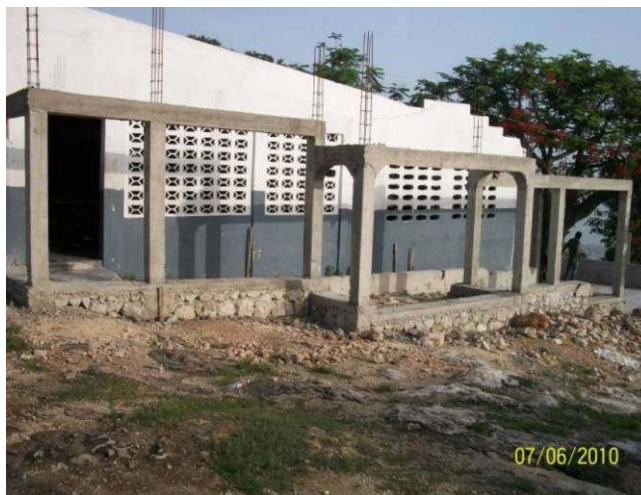
Travaux de consolidation et de renforcement des bâtiments du Collège Maranatha
