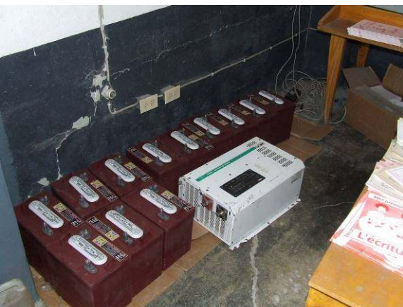
Matériel électrique de sécurité : éclairage de sécurité.
